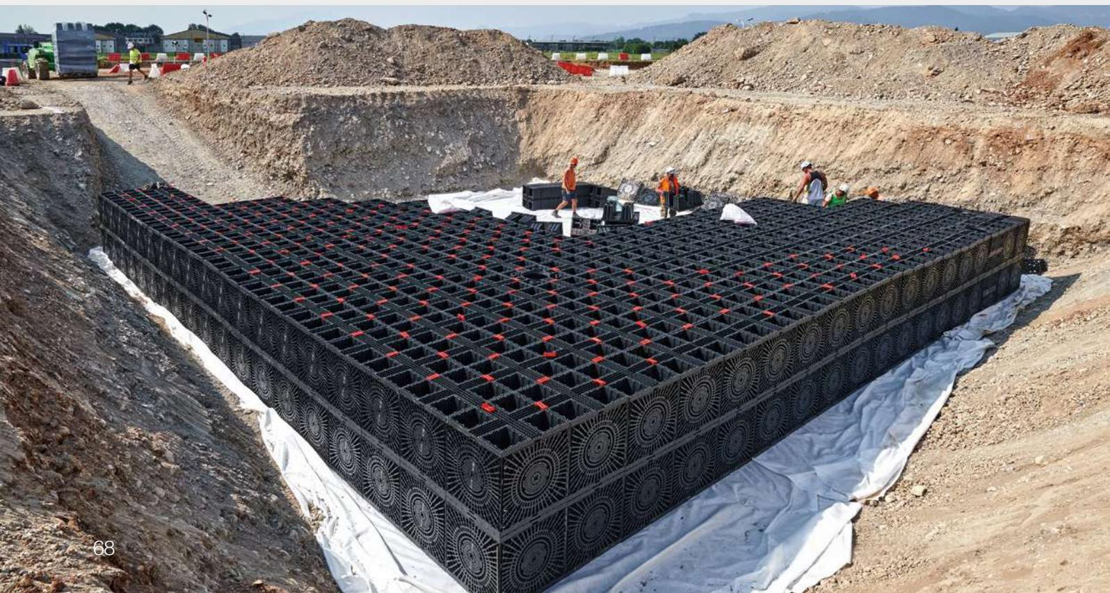
**ELEMENTO MODULARE A STRUTTURA TRONCOPIRAMIDALE CAVA**
