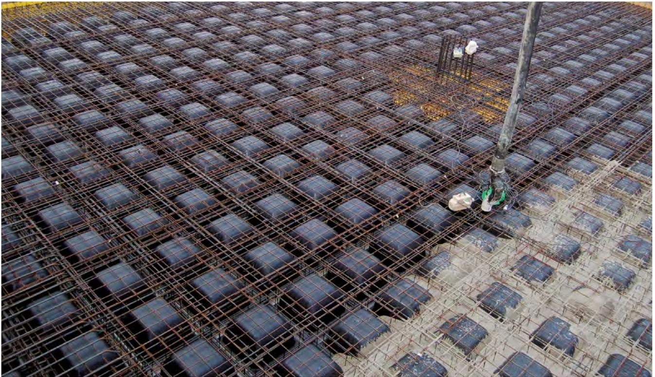
Sistema a casseri riutilizzabili per la realizzazione di solai cassettonati a configurazione bidirezionale a grandi luci. Skydome offre notevoli vantaggi dal punto di vista strutturale ed architettonico.
