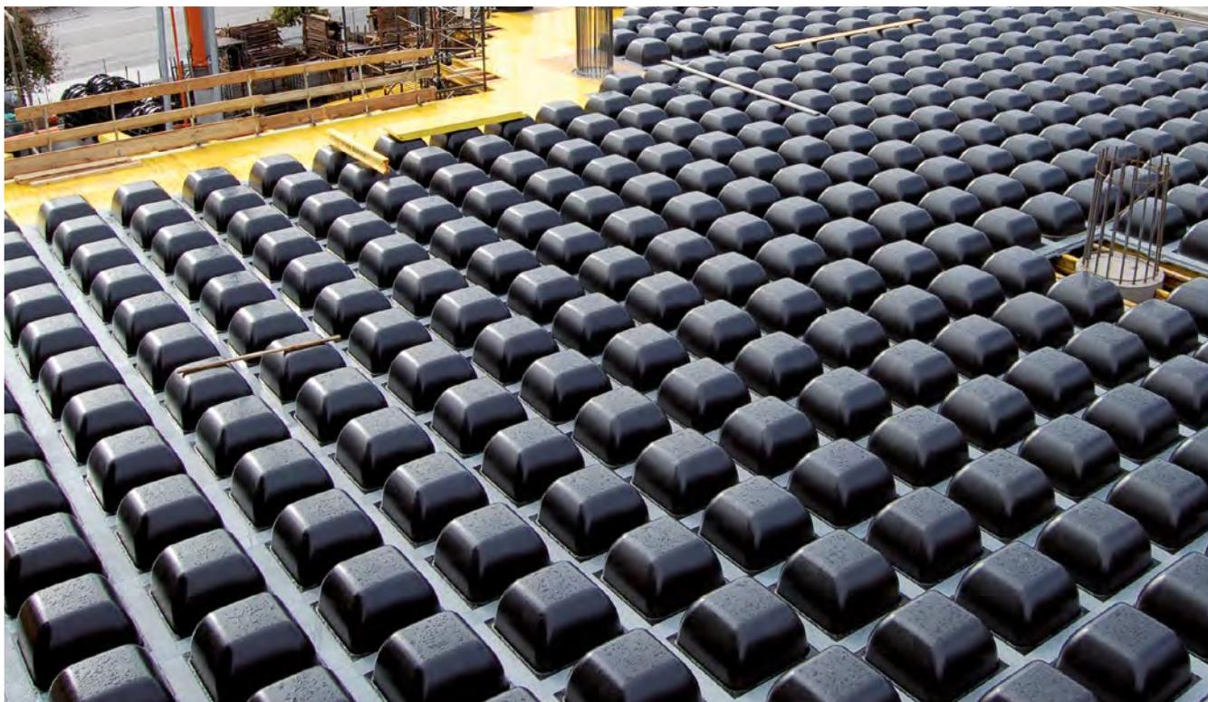
Sistema a casseri riutilizzabili per la realizzazione di solai cassettonati a configurazione bidirezionale a grandi luci. Skydome offre notevoli vantaggi dal punto di vista della leggerezza e del riutilizzo.
