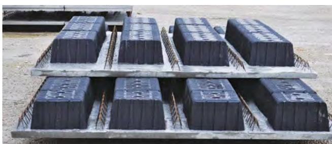
La lastra comunemente chiamata “predalle” viene definita semi-prefabbricata in quanto una parte (solitamente composta da lastra di base, tralicci di armatura ed alleggerimenti) è realizzata in stabilimento mentre il completamento, composto da armatura superiore e finitura, è realizzato direttamente in cantiere.
