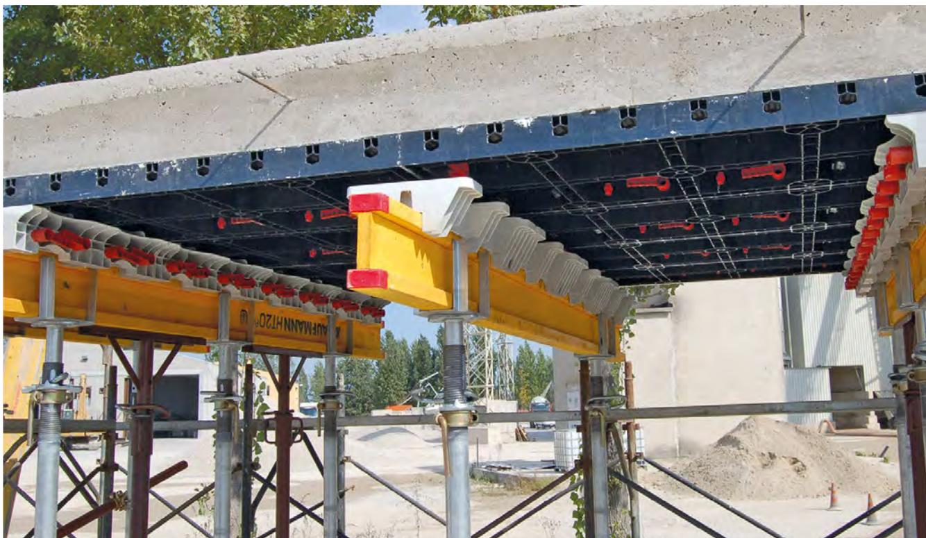
Sistema di casseforme modulari e riutilizzabili per la realizzazione di piani di cassero per il getto di solai ad intradosso piano.
