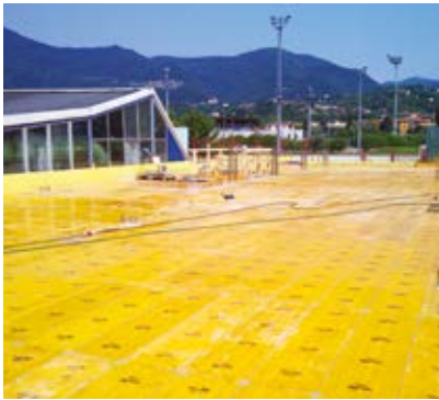
① PREPARACIÓN TABLERO DE BASE
