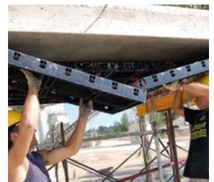
⑧ DESENCOFRADO PANELES GEOPANEL
