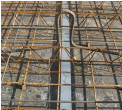
④ COLOCACIÓN ENCOFRADO
