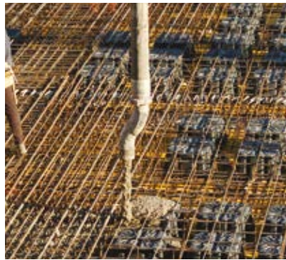
⑤ HORMIGONADO PRIMERA FASE
