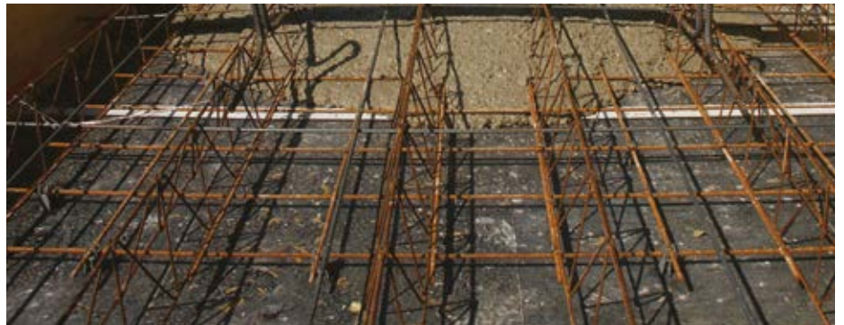
⑤ HORMIGONADO CLS
