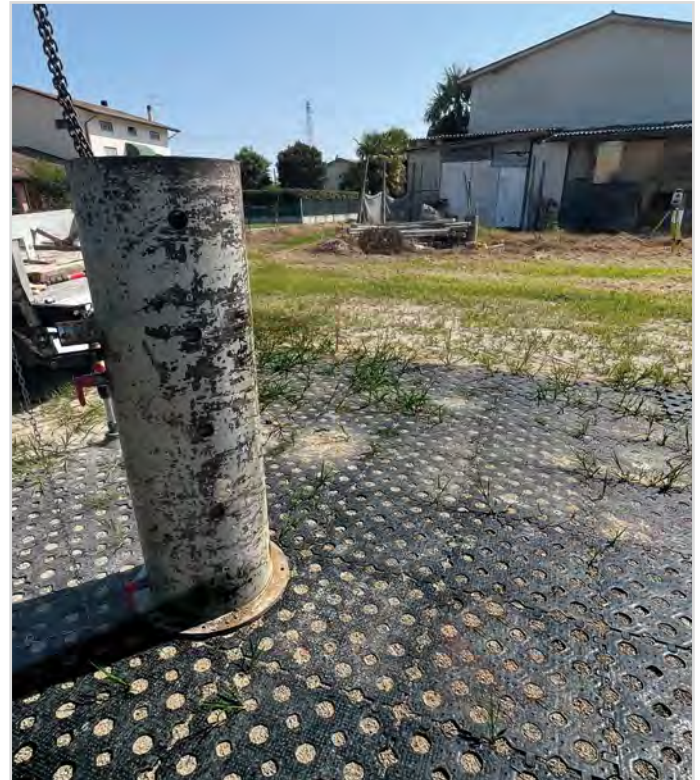
Test in situ di una nuova griglia per terreni
