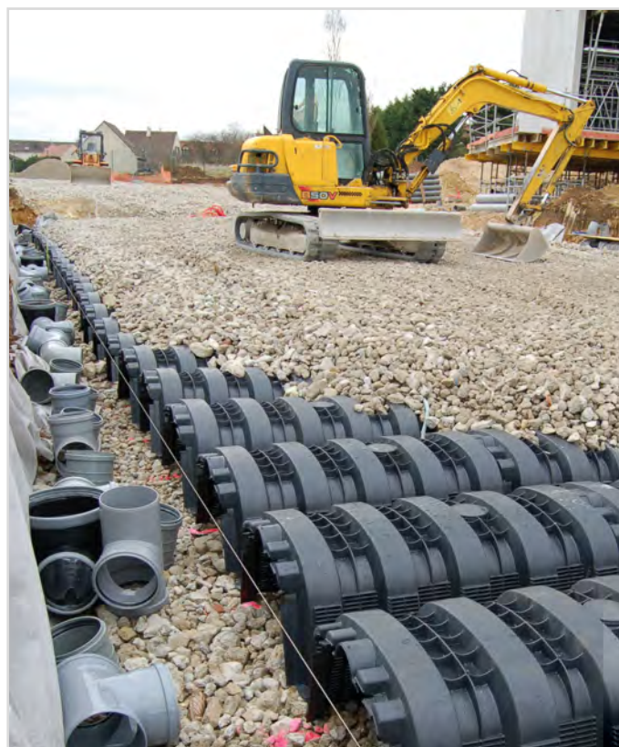
Cantiere Drening generale di Marchesini Group, Francia
