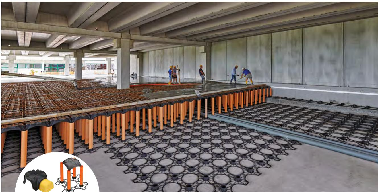
Modulo e Elevator consentono di riempire lo spazio tra il livello della fondazione e quello di calpestio in tutti i tipi edificio (residenziale, commerciale, direzionale etc). L'ufficio tecnico di Geoplast è in grado di sviluppare il progetto in modo da consentire il passaggio anche di carichi pesanti ove necessario.
