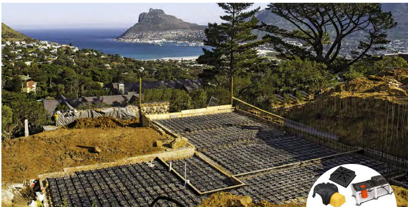
Le argille espandenti sono presenti in molte parti del mondo e sono un problema non indifferente per la stabilità delle costruzioni. Il sistema di fondazione deve essere in grado di sopportare movimenti differenziali del terreno senza cedimenti.
