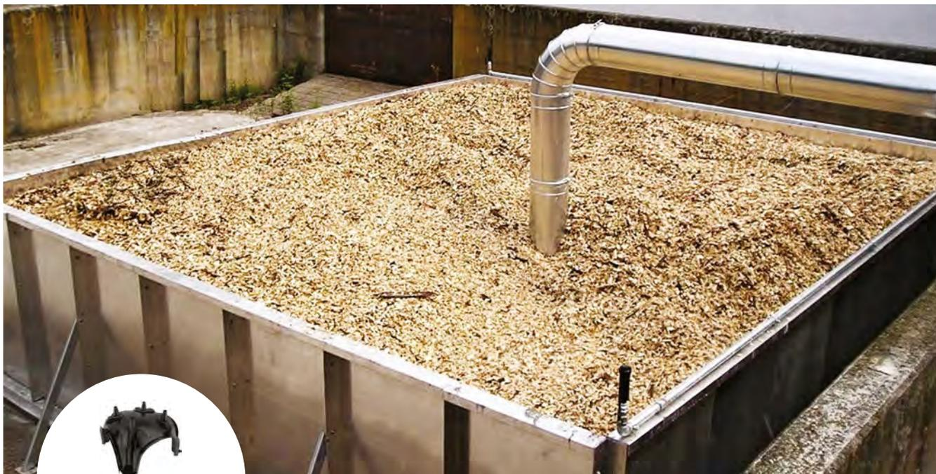
La biofiltrazione è un trattamento di depurazione delle emissioni gassose basato sul processo di ossidazione biochimica. Gli effluenti gassosi, incanalandosi attraverso le intercapedini create da Biomodulo, raggiungono il letto filtrante (cippato, torba, frazioni di concilie) che agisce come un elemento di rimozione naturale delle sostanze maleodoranti, restituendo aria pulita all'ambiente.
