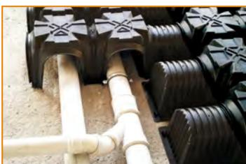
Passaggio impianti, gestione di argille gonfianti, pavimenti sopraelevati in CLS sono solo alcune delle applicazioni che la flessibilità del sistema permette.
