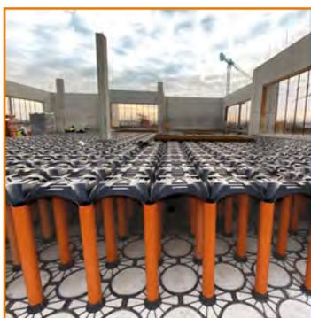
Ci sono numerose situazioni in cui le condizioni di progetto limitano il peso ammissibile del materiale di riempimento. Con i casseri Geoplast il progettista può prevedere con grande precisione il peso del riempimento; nel contempo può prevedere un agevole passaggio di impianti nella cavità creata dai casseri.
