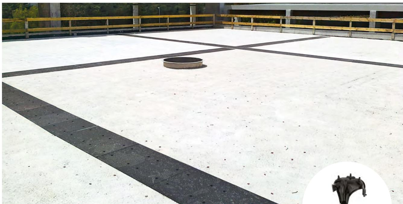
Nel processo di compostaggio il flusso dell'aria ha una importanza fondamentale. Biomodulo distribuisce l'aria in modo omogeneo nella massa dei rifiuti, garantendo così una corretta degradazione della sostanza organica e un compost di qualità.
