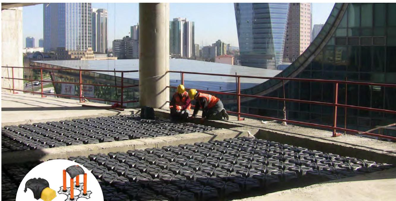
Modulo offre notevoli benefici anche in termini di alleggerimento, sostituendo efficacemente altri materiali più pesanti, ingombranti o inquinanti. Riducendo il peso dei solai è possibile ridurne lo spessore e di conseguenza il carico totale che va a gravare sui pilastri e sulle fondazioni dell'edificio.
