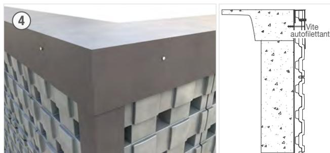
Posizionare il foglio di cartonplastico sopra a Defender e fissarlo con le viti autofilettanti (nel caso di altri materiali utilizzare collanti con analoga funzione).
